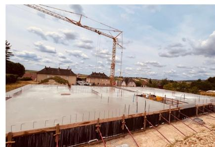
Tel un jeu de construction, les pièces de béton livrées d'usine, d'un poids de 6 à 7 tonnes chacune, sont montées les unes à côté des autres et très vite, à peine 1 mois après, fin juin, la dalle supérieure est coulée. Entre temps, il a fallu mettre en place une forêt d'étais pour soutenir l'ensemble et des tonnes de ferrailles ont été tressées pour armer le béton de la dalle. Il faudra 1 mois de plus pour maçonner le niveau supérieur et fin juillet la dalle de toit est coulée.
